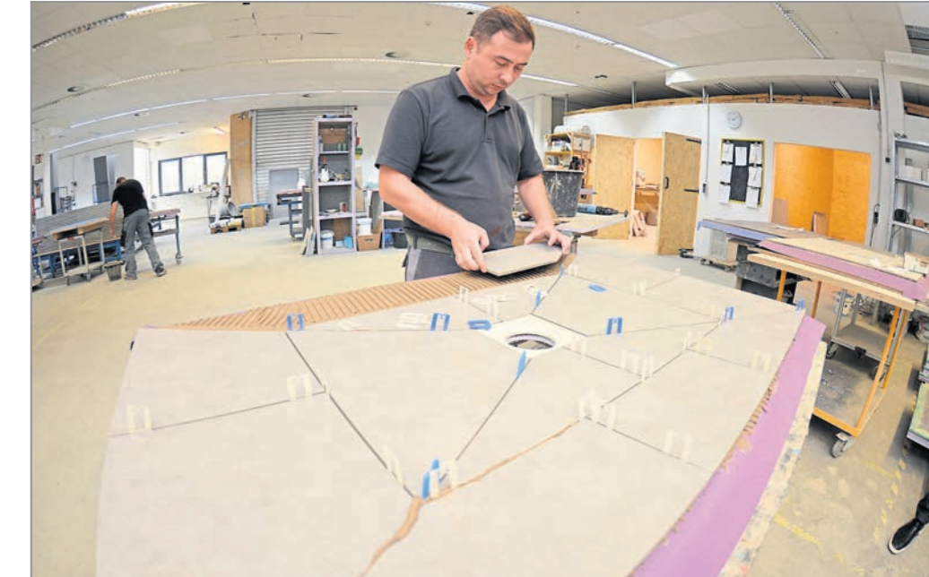
Die Fliesenarbeiten finden bereits im Werk auf vorgefertigten Platten statt, hier ausgeführt von Mitarbeiter Wladislaw Schwarz.
