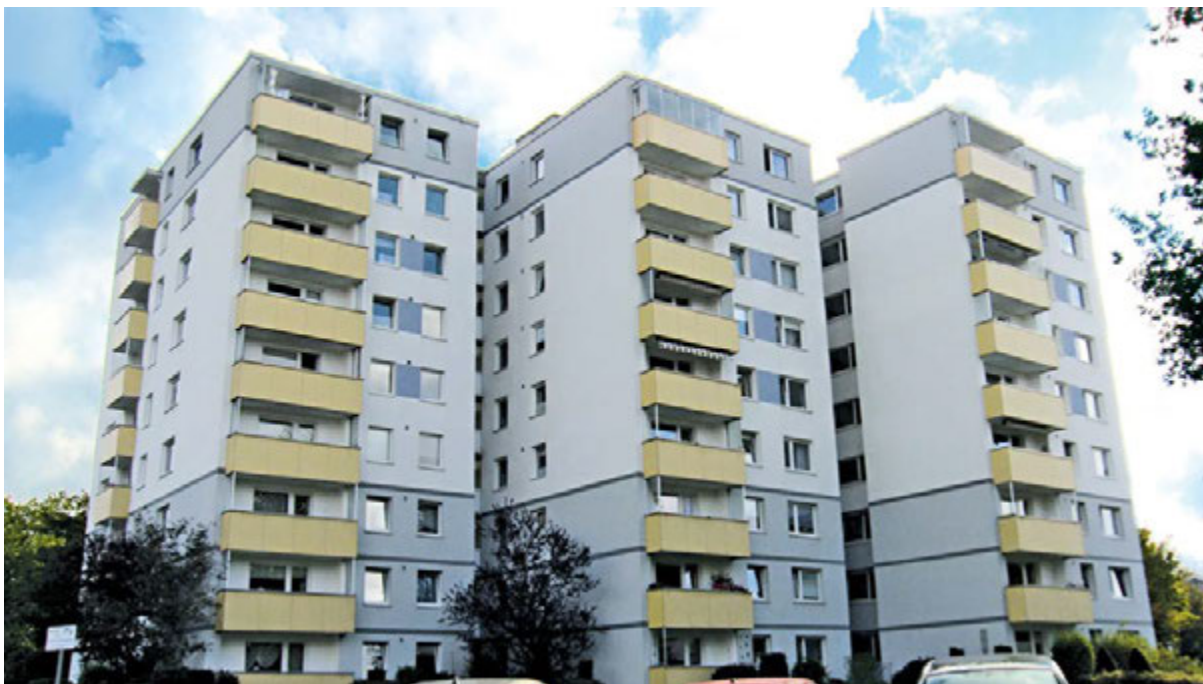
Badmodernisierung im Bestand: Bäder und Stränge dieses Hochhauskomplexes in Kiel wurden komplett saniert
