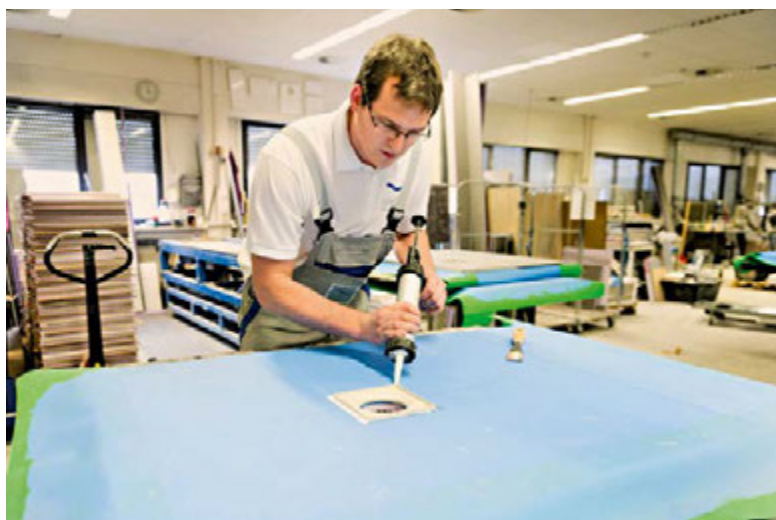
Spart Zeit: Ein Mitarbeiter fertigt im Werk den Boden einer Dusche an
