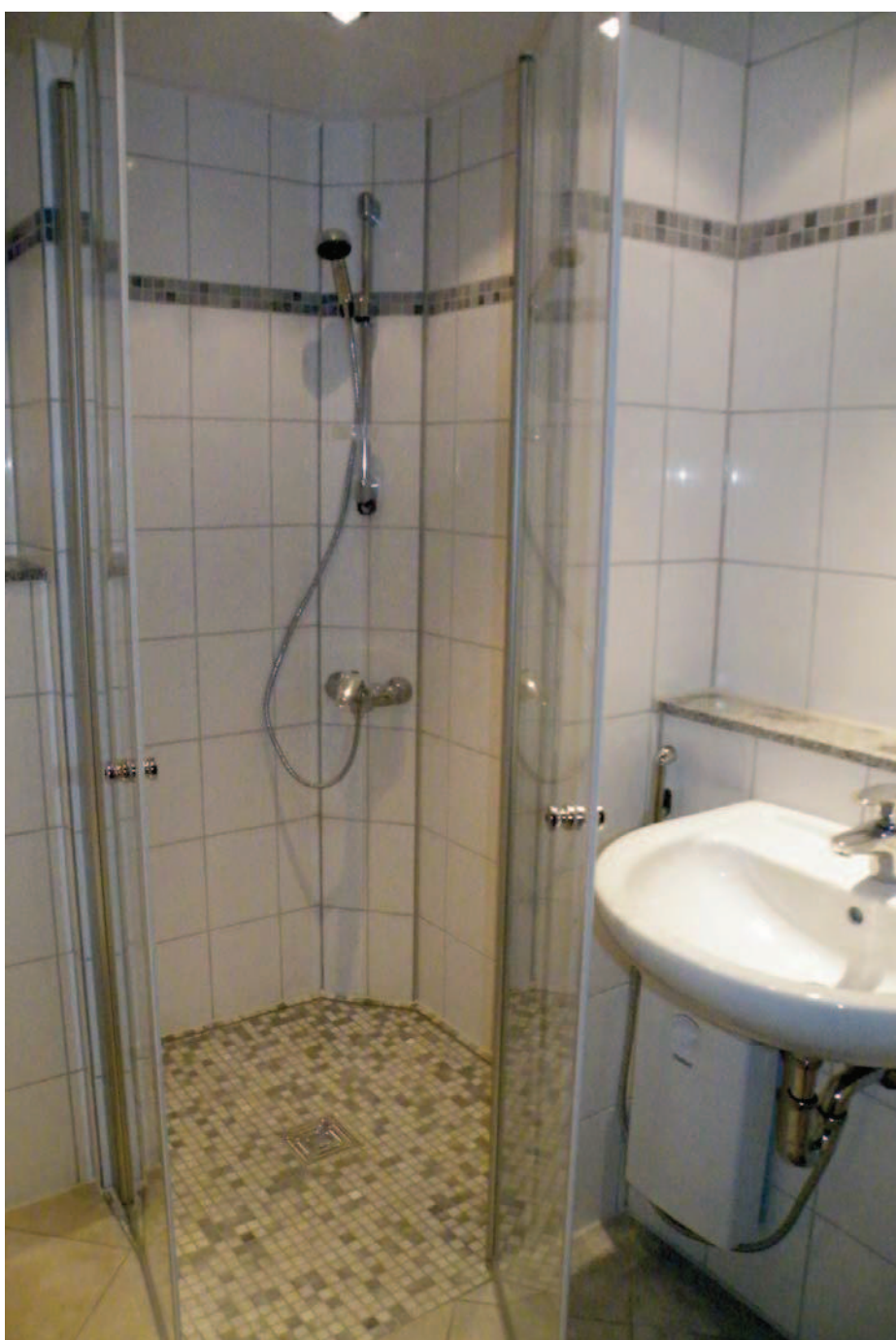
Fertiges Bad mit barrierefreier Dusche
