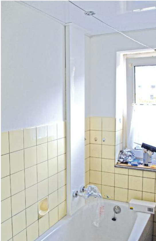
Ohne Bohren: Das weiße Modul auf den Fliesen enthält die neuen Leitungen für die Badewanne.
