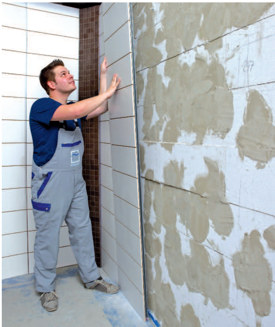
Badrenovierung in sieben Arbeitstagen: Vorgefertigte Wandelemente machen es möglich.
