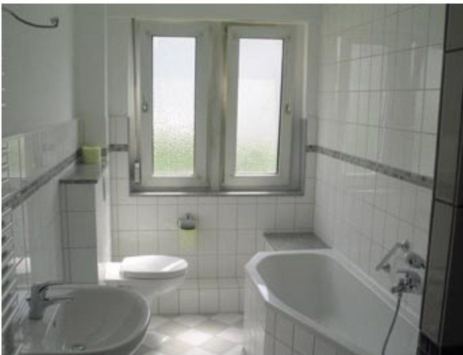
Fertiges Bad mit Raumsparwanne
