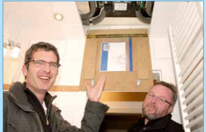
▲ Wolfgang Fischer GWG Köln-Sülz eG und Peter Hingst erklären den zentralen Anschlusspunkt für Wasser- und Elektroleitungen.
