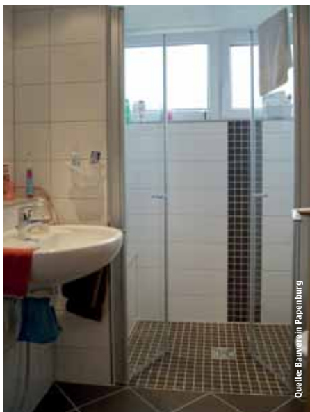
Das fertig eingebaute Bad mit barrierefreier Dusche
