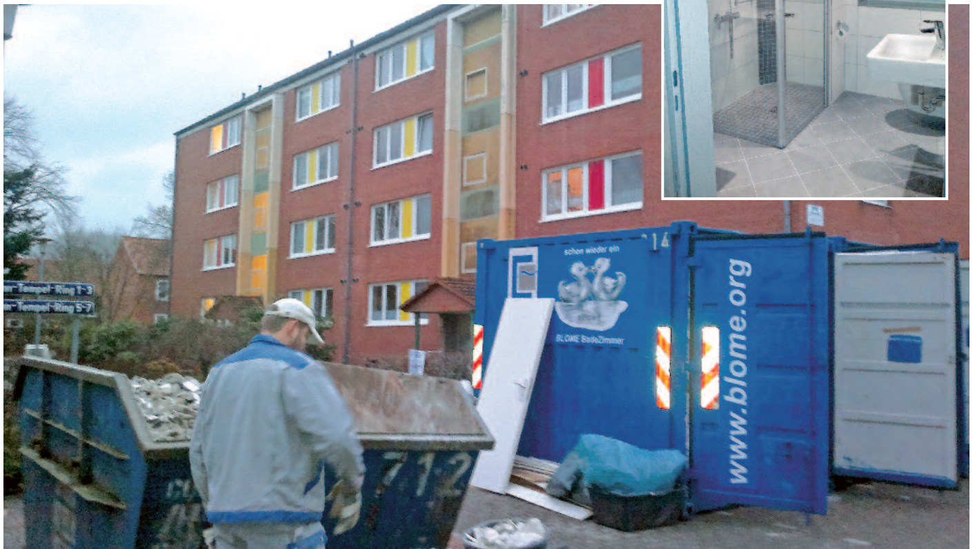
Baustelle am Hermann-Tempel-Ring 5 bis 7 in Leer von außen. Rechts sieht man den Container, in dem die vorgefertigten Badwände angeliefert wurden.
