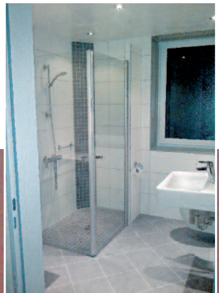
Fertiges Bad mit barrierefreier Dusche in Leer
