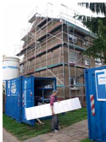
Spart Zeit: ein Blome-Monteur mit einer vorgefertigten Badwand unter dem Arm
